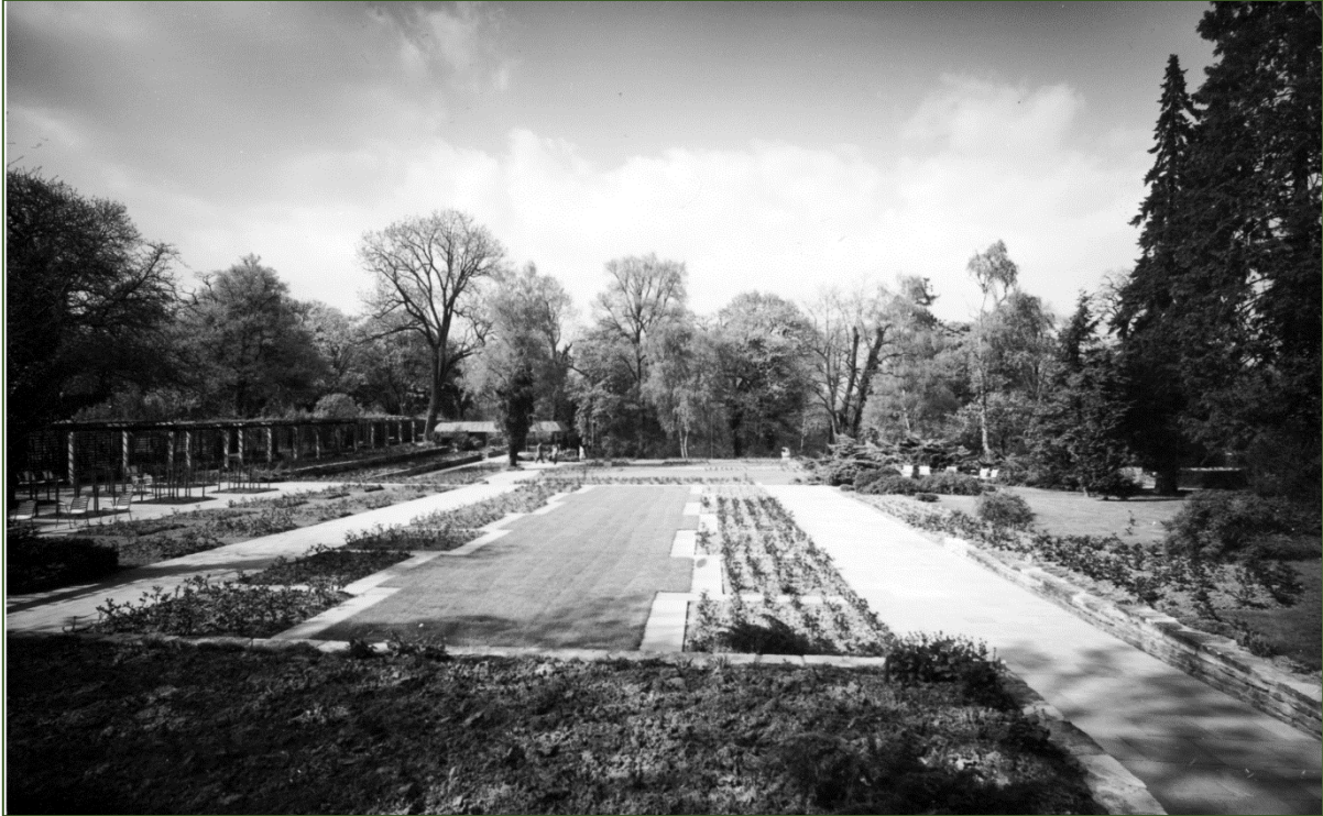
Abb. 98: Blick über die neu gestaltete mittlere Terrasse nach Norden, um 1962
